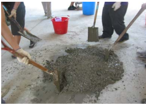
攪拌混凝土
